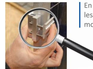
En vous aidant de la bride simple, alignez les têtes de vis avec le haut du cadre du module PV.
