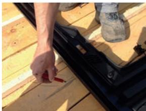
Tracez sur les chevrons ou fermettes, la position des planches du platelage en face des ouvertures.
